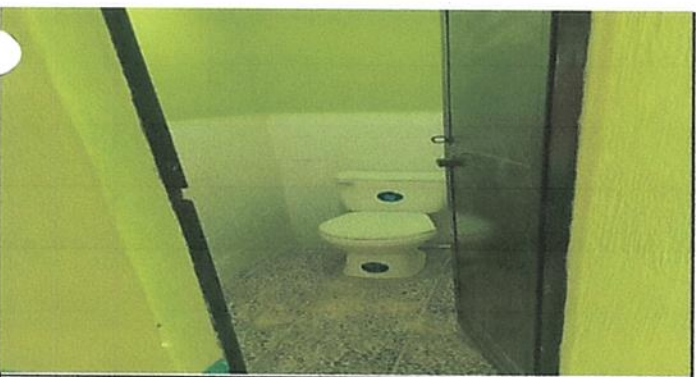
Foto 5: TRABAJO DE BAÑOS Y PUERTAS FINALIZADO
