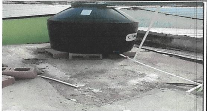
Foto 2: COLOCACIÓN DE UN TANQUE DE AGUA POTABLE
