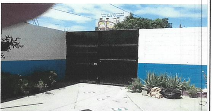
Foto 6: REPARACION DE PPORTON Y PINTURA TERMINADO
