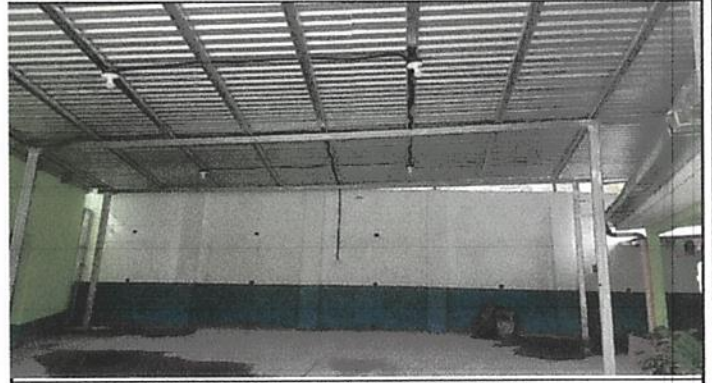
Foto 2: GALERA TERMINADA CON SU RESPECTIVA LUZ
